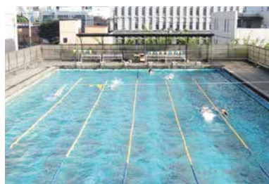
武道館屋上にある屋外プール
